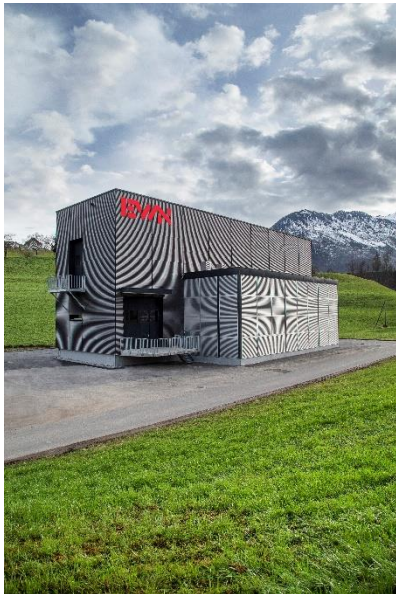
Bildlegende: EWN Unterwerk Fadenbrücke
