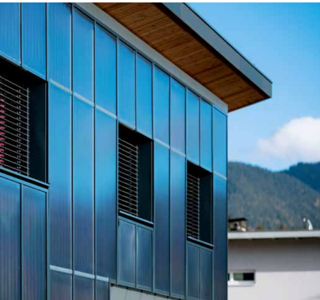
Solarfassaden wirken der Winterstromlücke entgegen, indem sie die Strahlen der im Winter tiefer liegenden Sonne besser einfangen.
