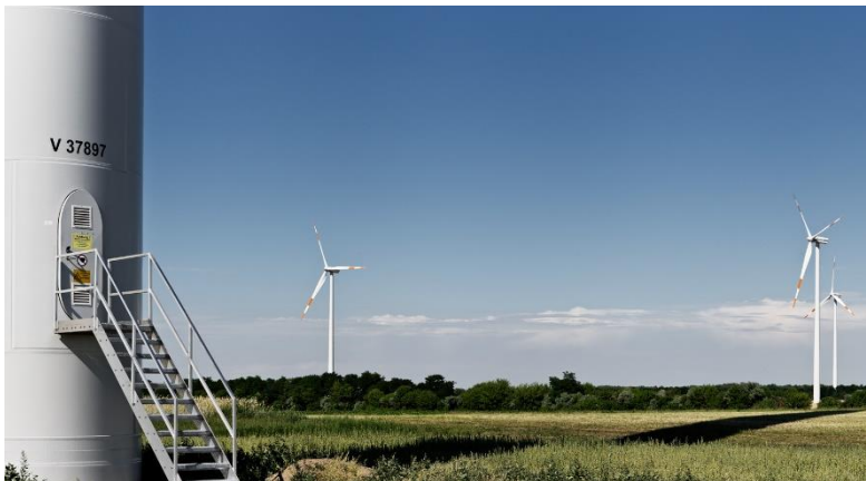
Windpark Lübbenau (Brandenburg)
