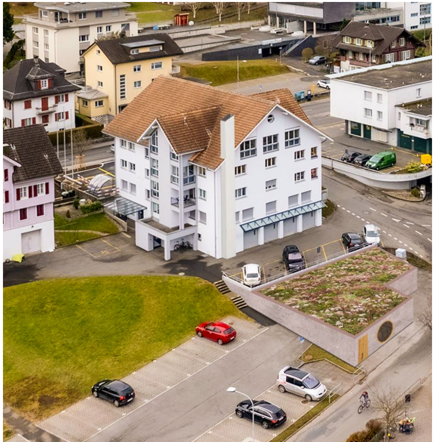
Die geplante Wärmezentrale beim Gemeindehaus
